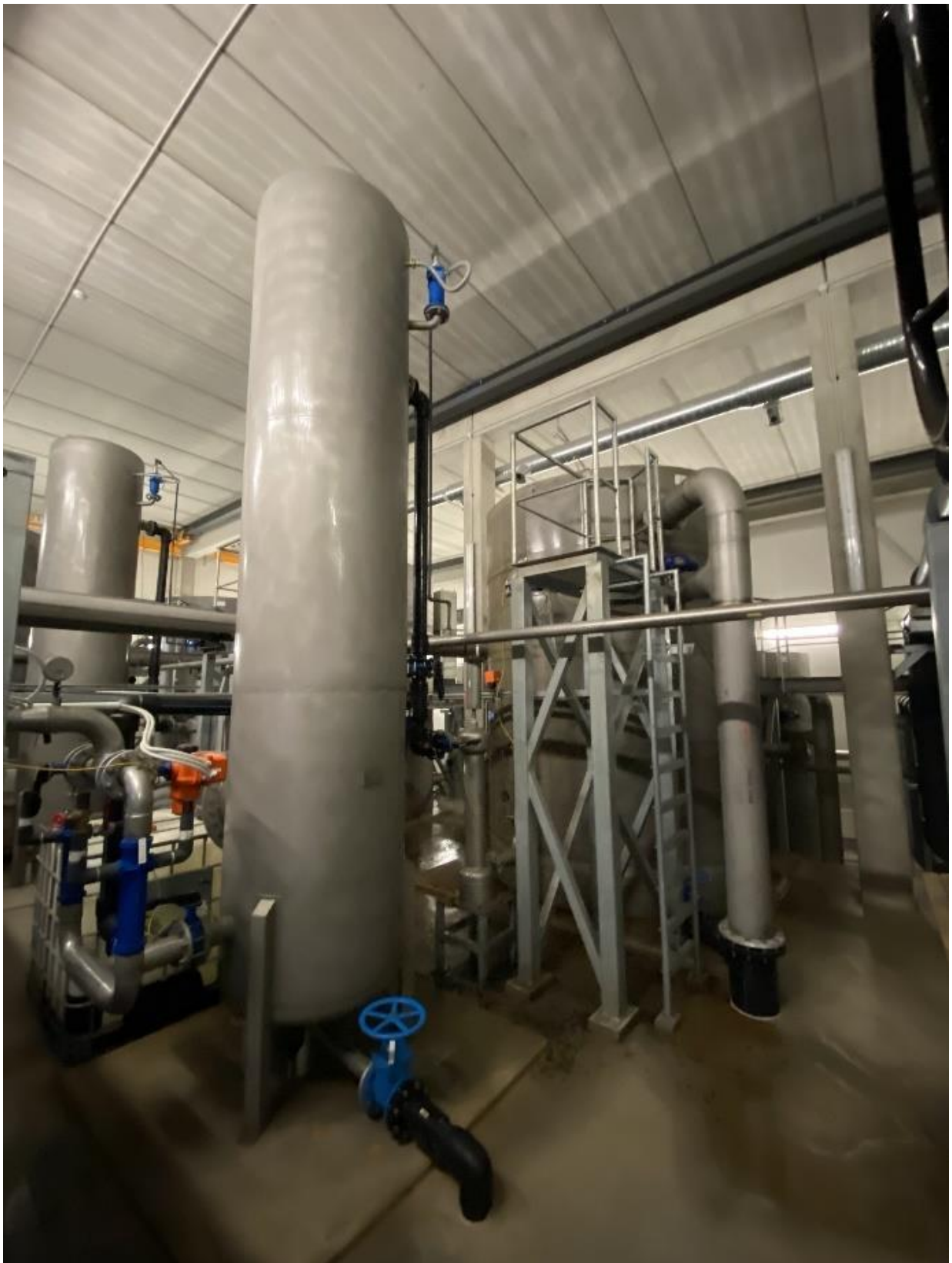
Foto 4-4 Viimsi veetöötusjaama tehnoloogiline osa, filtrid
